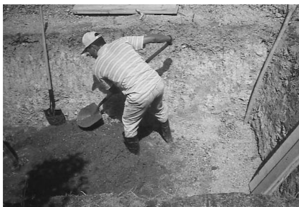
Excavación del pozo, La Ceiba, Sabana Grande, F.M., Honduras.
