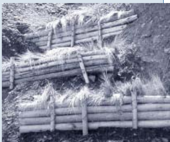
Medidas bio-mecánicas para la estabilización de las laderas en áreas críticas.
