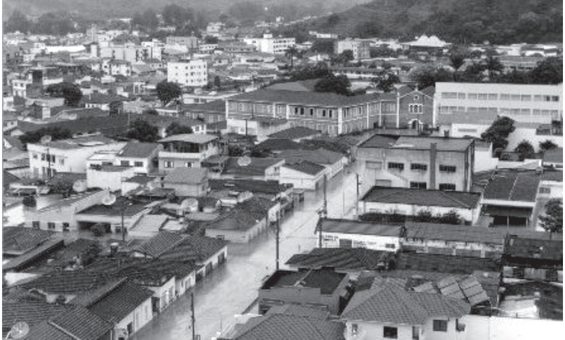
Figura 5. Itajubá: foto da inundação de 2000 Fonte: Defesa Civil, 2000.
