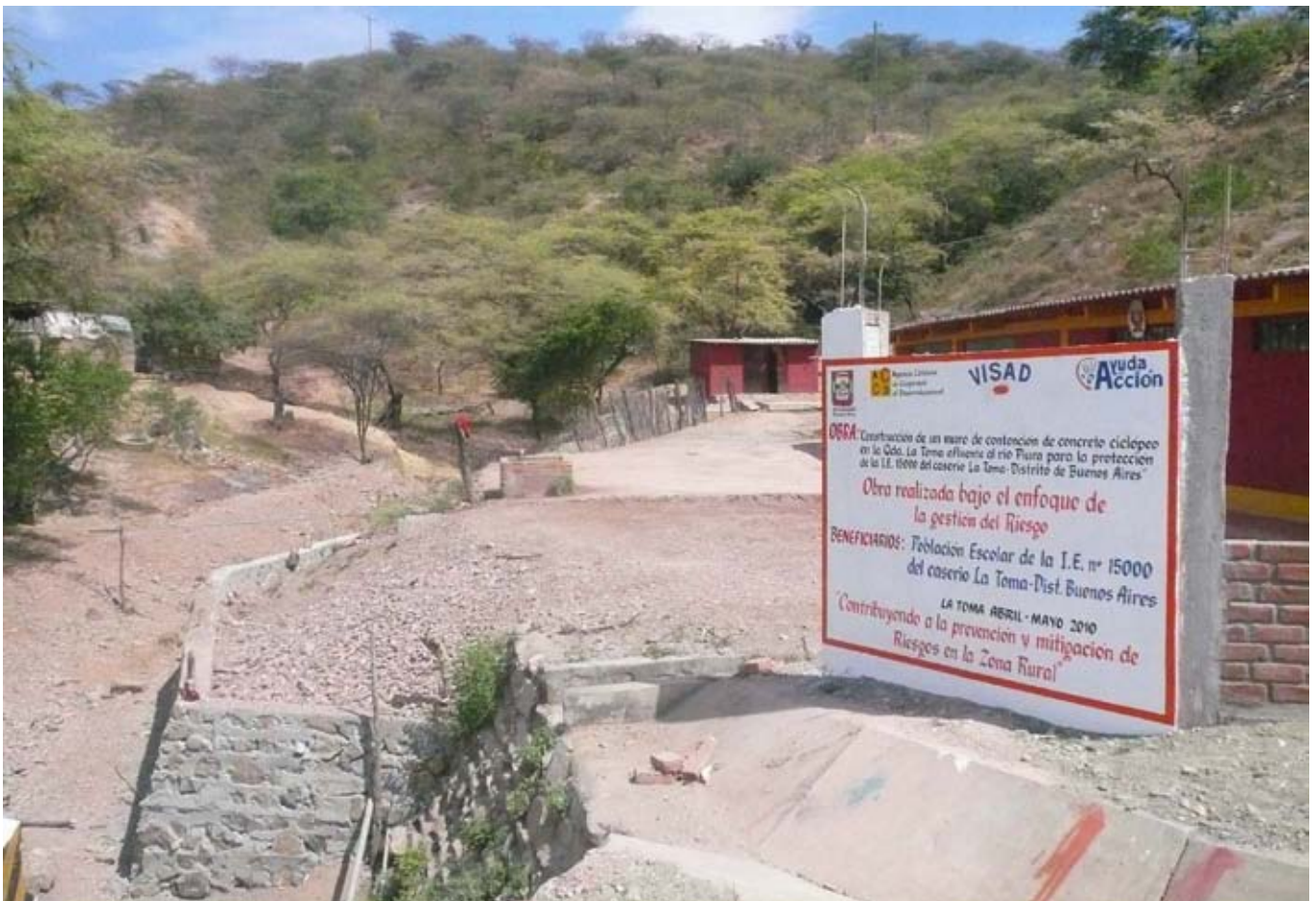
Obra pública construida bajo criterios de gestión del riesgo en Piura, 2010.
