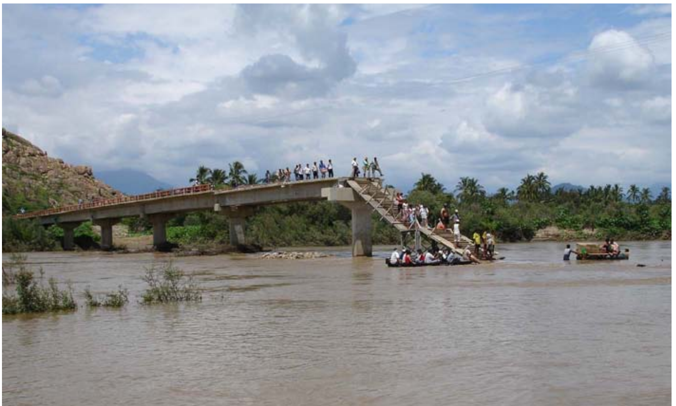
Puente Carrasquillo destruido por el FEN 1997/1998 en Piura.
