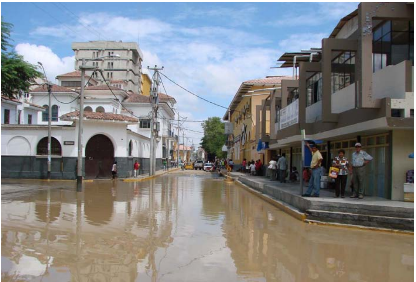
Inundación en la ciudad de Piura, 2005.
