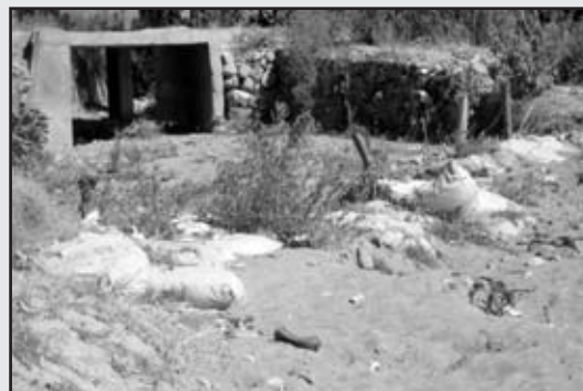
Figura 14. Falta de infraestructura hidráulica.
