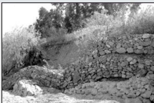
Figura 15. Daños a los gaviones.
